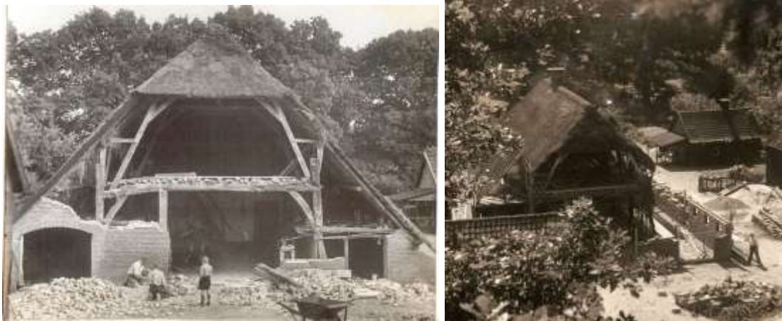
Afb. 80 De achtergevel tijdens de verbouwing in 1951 (archief fam. van der Waals).
