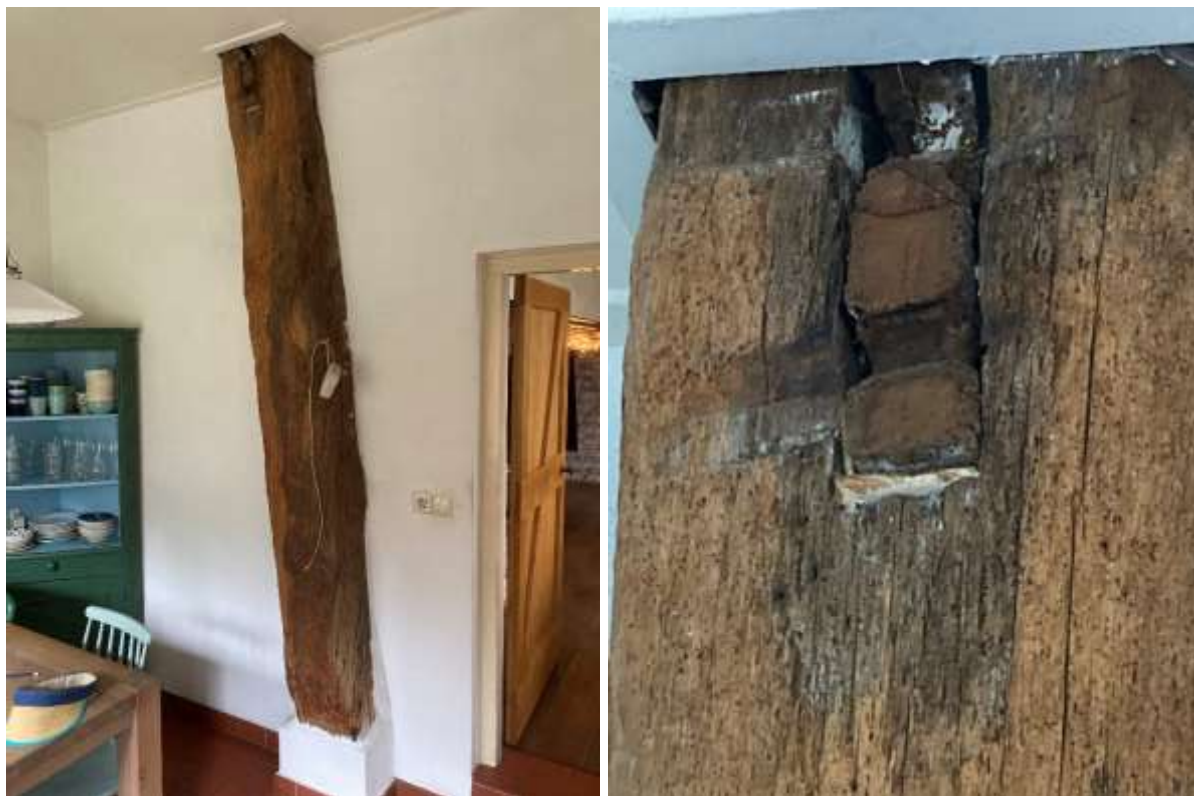
Afb. 76 Stijl in het voorhuis met detail van de aansluitende gebintbalk (P. Schut).
