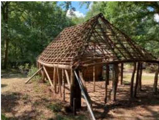
Afb. 97 Het hooischot nadat de bekleding is verwijderd en na de restauratie (P. Schut).
