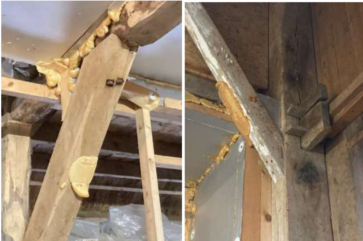
Afb. 77 Korbelen en pen- gat verbindingen in het achterhuis (P. Schut).
