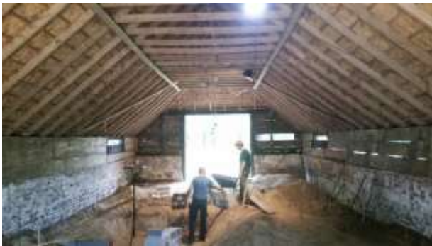
Afb. 86 De binnenzijde van de achterste schaapskooi in 2017 (foto P. Schut).
