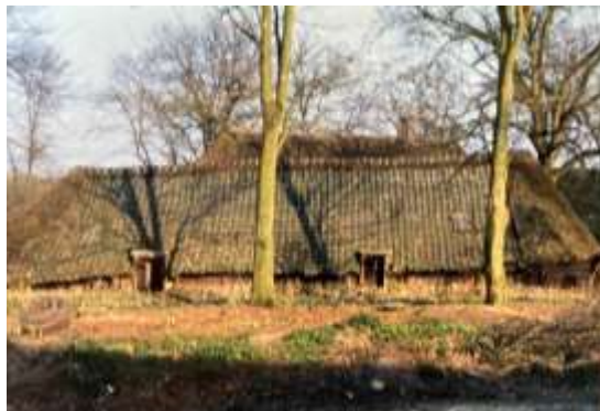
Afb. 85 Boven: De voorste schaapskooi met vijfroedige berg (voor 1951) en in 2020 (archief fam. van der Waals en P. Schut) Onder: bouwtekening uit 1953 toen deze als varkensschuur werd ingericht. Het dak aan de achterzijde werd voorzien van dakpannen inclusief een aangepaste draagconstructie. Bij de restauratie in 1991 werd de schaapskooi teruggebracht naar de oorspronkelijke situatie (archief fam. Van der Waals).
