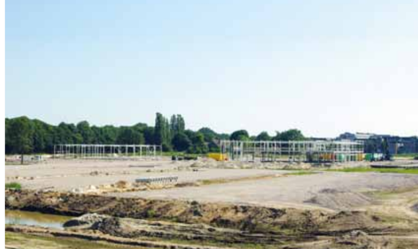
De bouw van de stalconstructie voor de hal van BCA zal net zoals de boerderij zijn sporen in de bodem nalaten (P. Schut)
